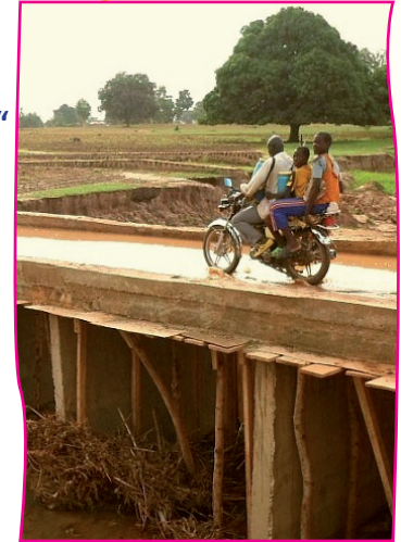
Brückenbau in Burkina Faso - unser Spendenprojekt
